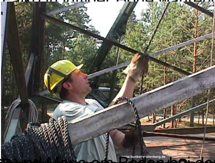
Konstruktion von einem anderen Tag: Absicherung nicht festiger Stahlgüter durch eine Kette aus Ketten. Einmalig, aber notwendig, um die Sicherheit zu gewährleisten.
