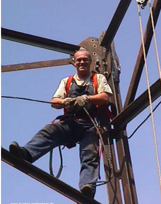
Falko in luftiger Höhe während der Montage...
